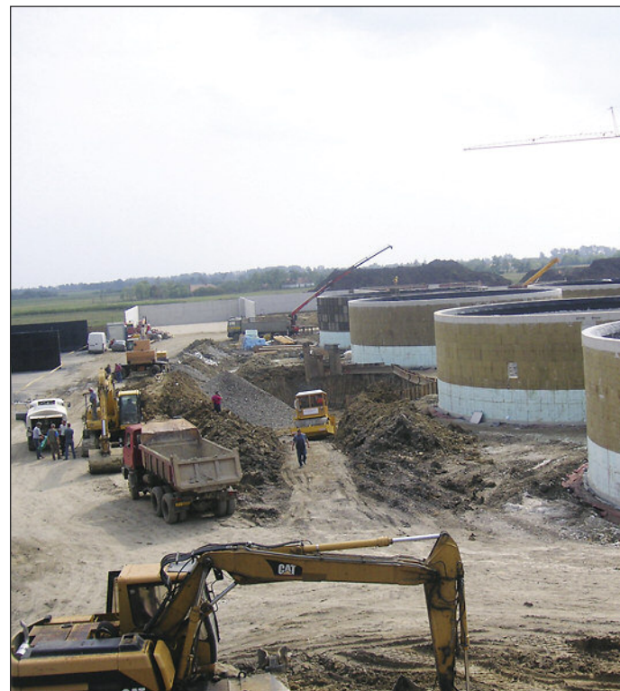
A szarvasi biogázüzem építését augusztusban kezdték el
