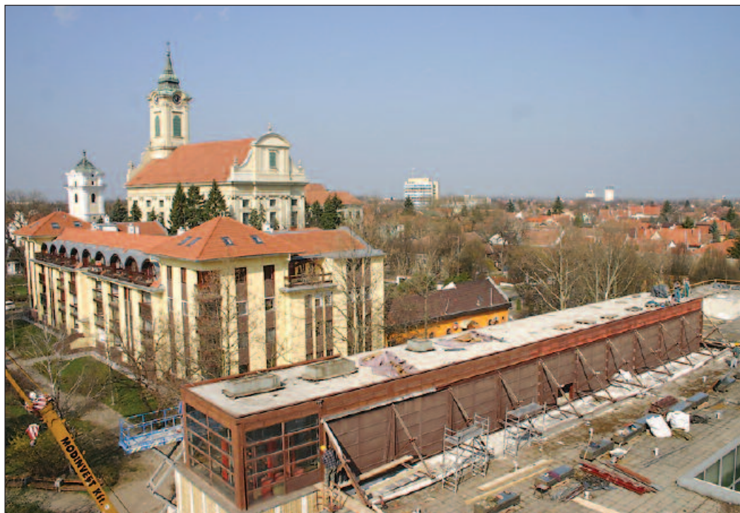
A Tudásház tetőszerkezetének felújítási és az emelet ráépítésének munkálatai
