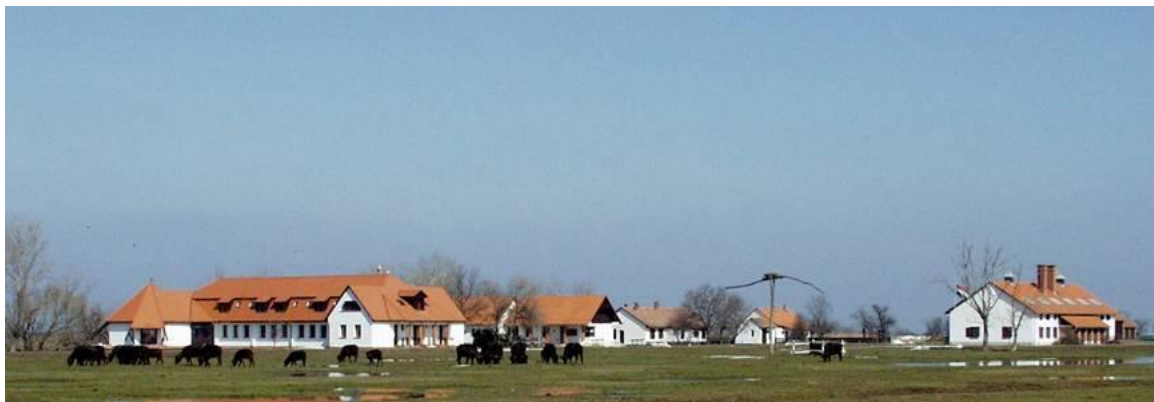
A Réhelyi Látogatóközpont épületegyüttese
